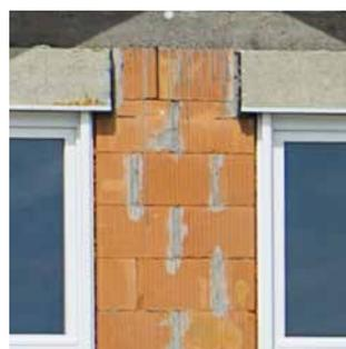
Detailsicht Neubau-Auflagerkasten, Mauerwerk mit beidseitigem Auflager
