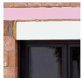
Detailsicht Aufsatzkasten, Mauerwerk als einfache Öffnung ohne Auflager
